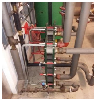
warmtewisselaars in warm tapwaterbereiding
