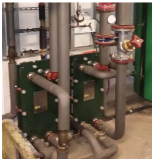
warmtewisselaars in warm tapwaterbereiding
