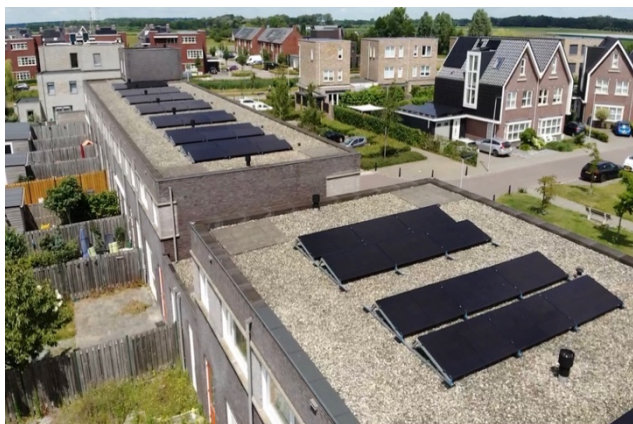
Zonnepanelen aan de Wevershof
